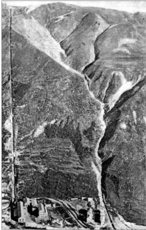
FIG. 1. Corrección hidrológico-forestal. Cuenca del torrente Eriñolo, afluente del río Flamisell en el Pirineo Catalán. Fuente: PATRIMONIO FORESTAL DEL ESTADO. Resumen en diez gráficos de la labor realizada en los años 1940-1953 , Madrid, 1954.
